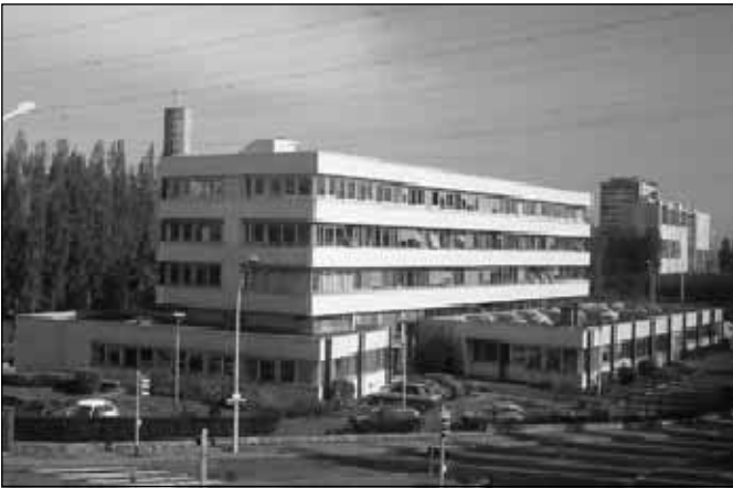
Head Office - Rosny sous Bois
